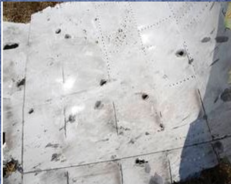
Einschusslöcher an der Außenhaut
